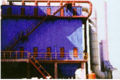
GA 系列大气清灰袋式除尘器清灰系统采用了高频振动加反吹风,反吹风由特殊
